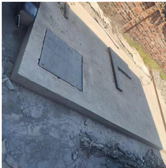
图 3-3 废水处理现场图（清水池）
